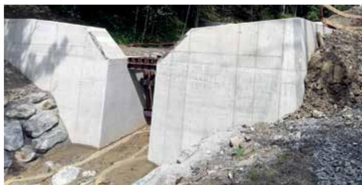
Weiter oben wurde eine sogenannte Konsolidierungssperre errichtet und die Bachsohle gehoben, damit es zu keiner weiteren Vertiefung und zum Ausreißen des Ufers kommt. In weiterer Folge stabilisiert sich der Hang. Die Ufersicherung im oberen Bereich soll mit „ingenieursbiologischen Maßnahmen“ erfolgen. Diese Zone des Kälberbichlbaches wird aufgrund ihrer Feuchtgebiete besonders sensibel und schonend behandelt. Mit „Piloten“, Bäumen und Weiden wird das Bachbett gesichert.
