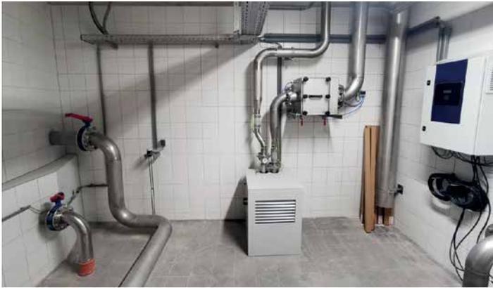
Kompressor mit lärmgeschützter Steuerung
