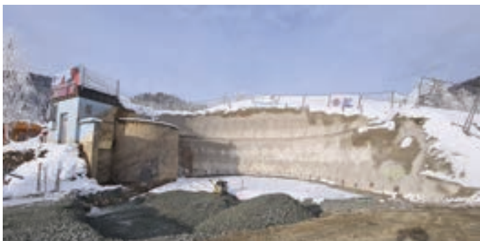
Baugrube fertig - Winterruhe 15.12.2020
