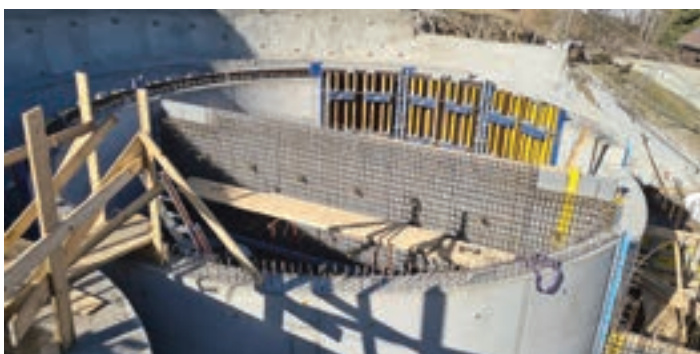
Wasserkammer-Trennwand 16.03.2021
