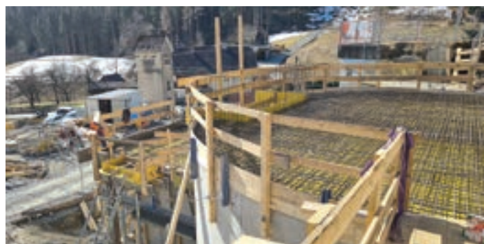
Wasserkammer + Rohrkeller-Decken 26.03.2021
