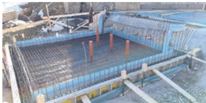
Bodenplatte-Schieberkammer 17.02.2021
